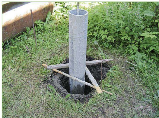
До схватывания раствора крепили столбики колышками, рейками и проволочными растяжками.
