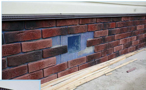
Плитку наклеивали, обходя продухи.
