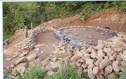
Укладка стенок из природного камня.
