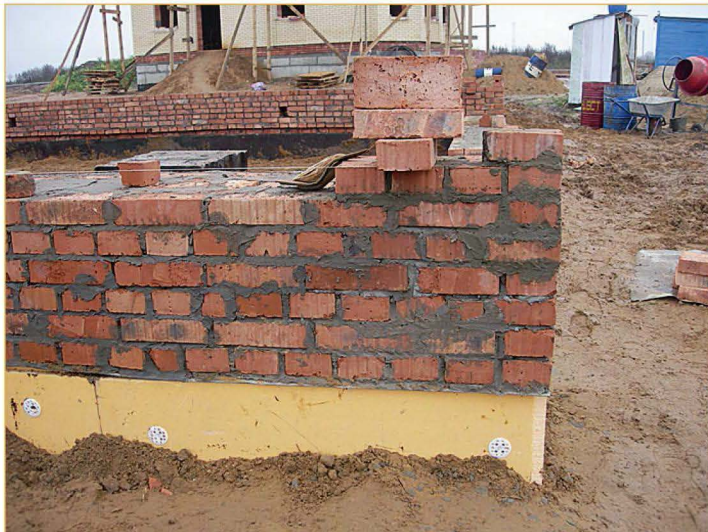
Утепление бетонного цоколя и подземной части фундамента.
