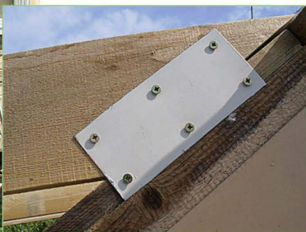
Крепил новые стропила саморезами с помощью самодельных накладных металлических пластин и уголков.
