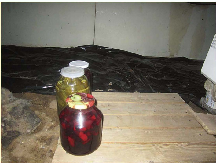
Вдоль цоколя уложена плотная полиэтиленовая плёнка.
