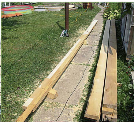
Шаблон для разметки новых стропил.
