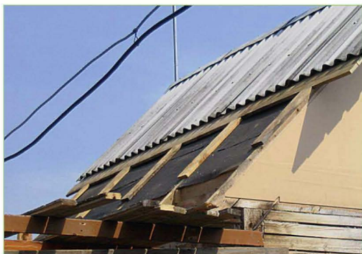
Часть шифера и обрешётки с крыши бани пришлось демонтировать.
