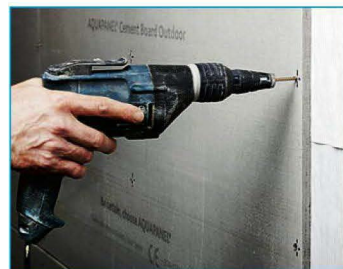
Акваплиту крепят шурупами.
