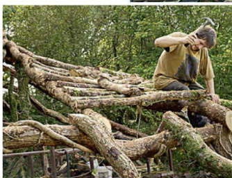
Все соединения каркаса, включая обрешётку, — на гвоздях.
