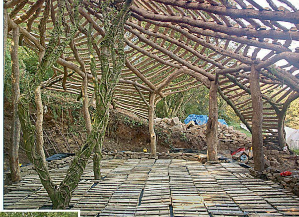
Готовый каркас жилища с деревянным основанием пола.
