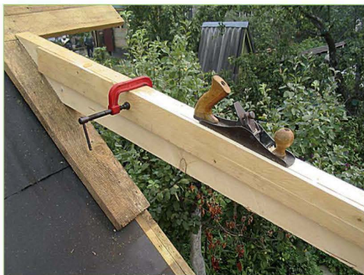
Доски для новых стропил были не очень ровными, поэтому их выпуклую сторону при разметке старался сделать вверх, чтобы потом сострогать лишнее.
