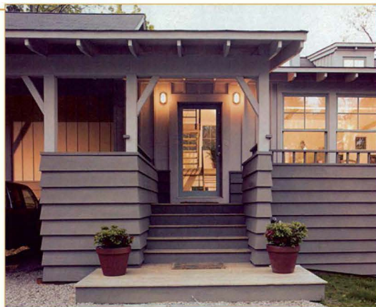
Секрет элегантности и симметрии наружной отделки дома кроется в использовании специальной фанеры, в вертикальные канавки которой с шагом 300 мм вклеены декоративные рейки. Оконные рамы и горбыльки переплёта установлены вровень с ними.
