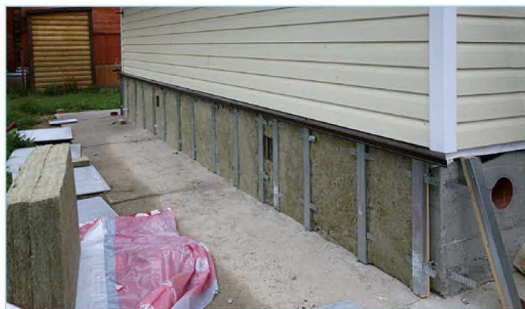
Для утепления использовали плиты базальтовой ваты Rockwool Light толщиной 50 мм.
