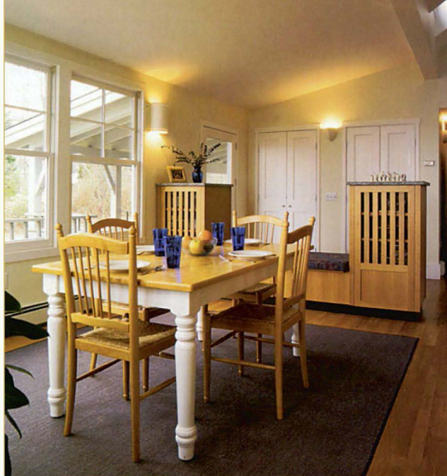
Зона столовой отделена от прихожей витринами-стойками со скамейкой между ними. Витрины сделаны из белого дуба и накрыты гранитными плитами. На их широких полках достаточно места и для безделушек, и для посуды. Фото по стрелке G на плане.
