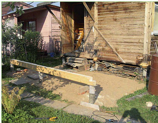
На готовые фундаментные столбики уложен первый брус нижней обвязки.
